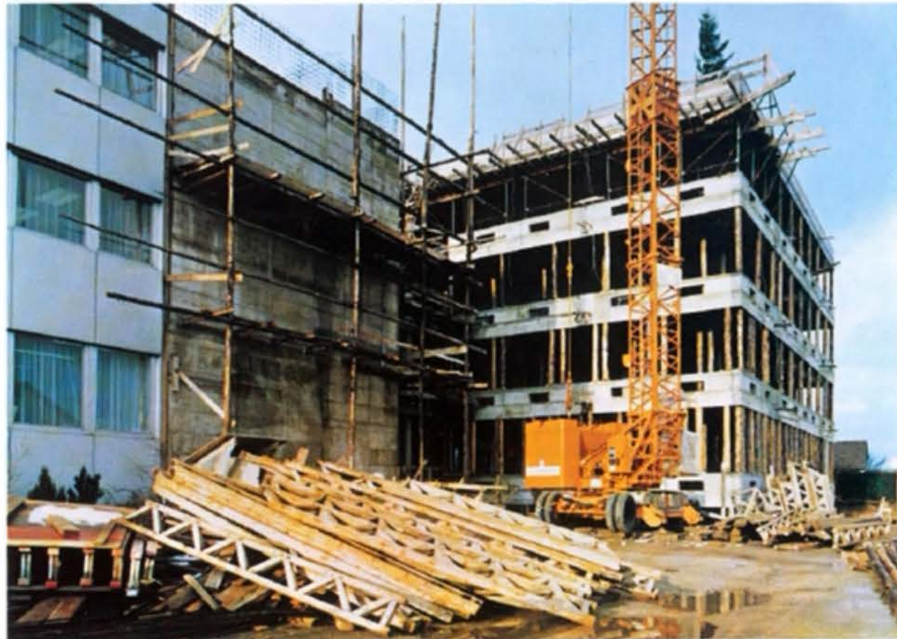
Ein Zwischenbau wird das 1969 fertiggestellte Verwaltungsgebäude mit dem soeben im Rohbau abgeschlossenen Erweiterungsbau zu harmonischer Geschlossenheit verbinden.
