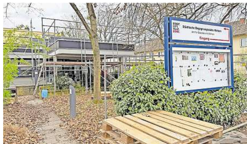
Die städtische Begegnungsstätte an der Utestraße wird saniert. FOTO: AXEL VOGEL
