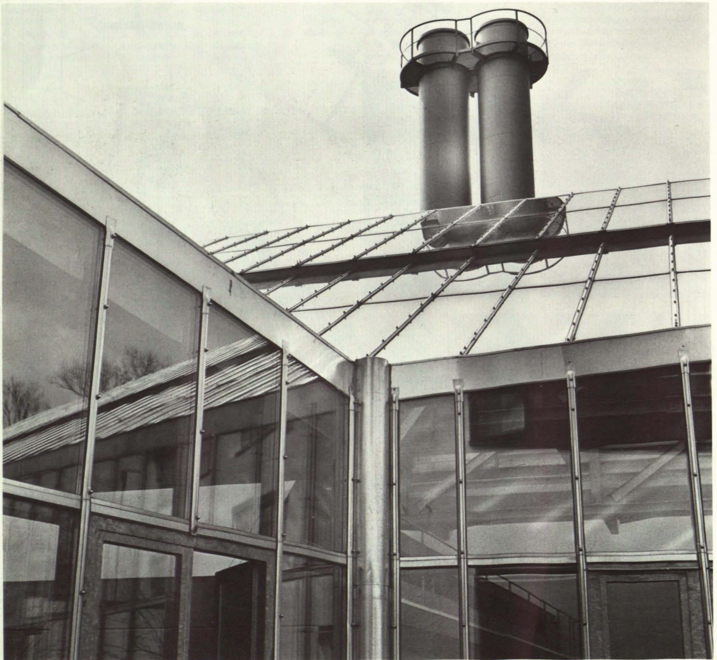
Abb. 6 Glasleisten und Abdeckungen sind aus Aluminium, die Türen sind verzinkt.
