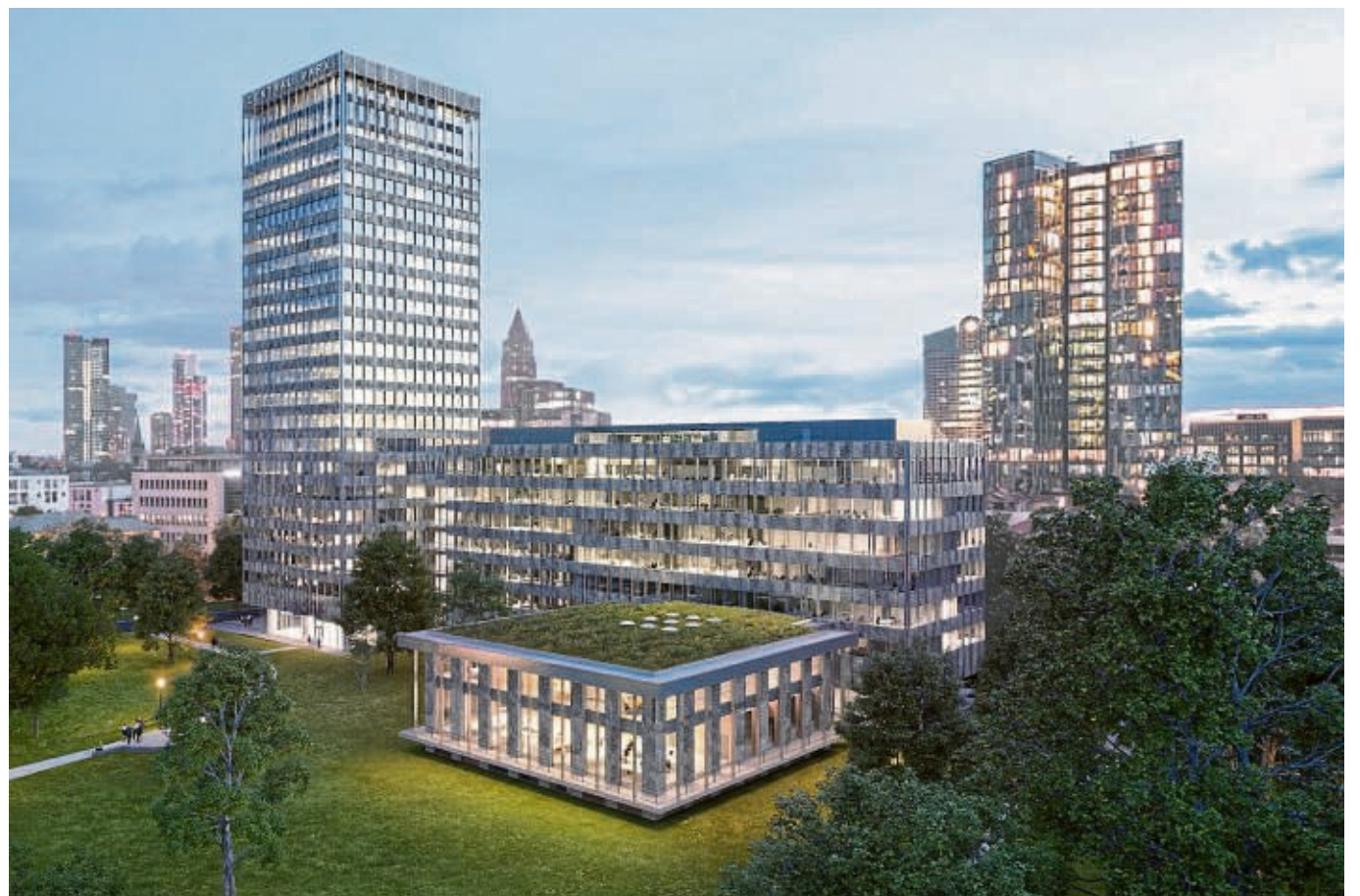
Entkernt und neu aufgebaut wird der BHF Tower am Rande des Rothschildparks. Moderne Büros entstehen in dem 82 Meter hohen Turm, der unter Denkmalschutz steht. VISUALISIERUNG: ABG REAL ESTATE GROUP
