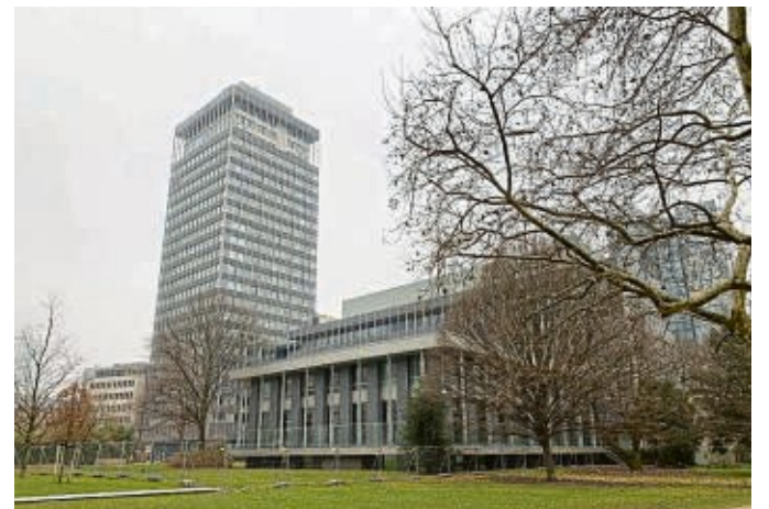
1965 wurde der BHF Tower fertig. In den kommenden vier Jahren wird alles neu gemacht. FOTO: MATTHIAS BITTNER
