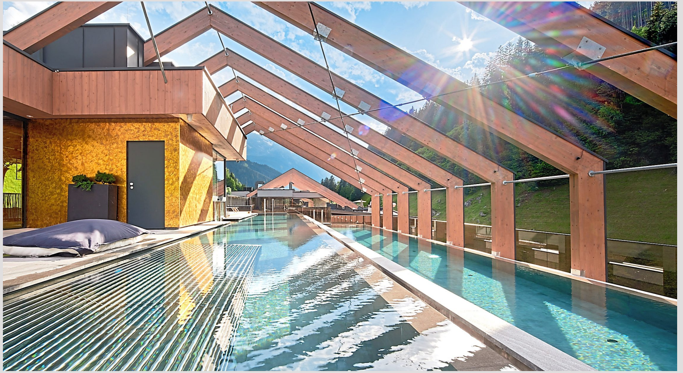
Spektakulär: der Infinitypool über zwei Ebenen auf dem Dach des „Luxury Mountain Resort ZillergrundRock“ im Tiroler Zillertal. Michael Huber (2)
