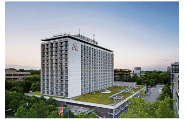
Ab Januar wird das Hilton für Umbauarbeiten bis 2029 geschlossen. HILTON
