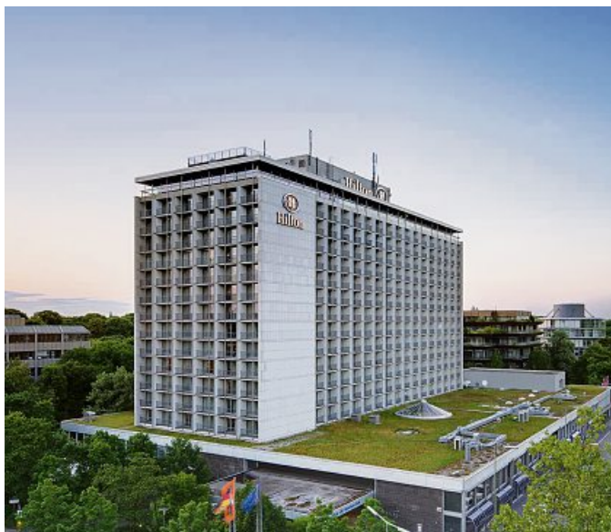
Ab Januar 2025 wird das Hotel Hilton für Umbauarbeiten bis 2029 geschlossen.
