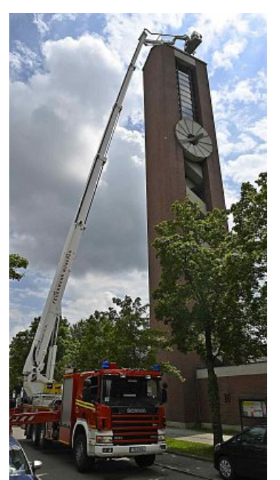
Die Feuerwehr sicherte das Dach der Kirche St. Helena in Obergiesing.
