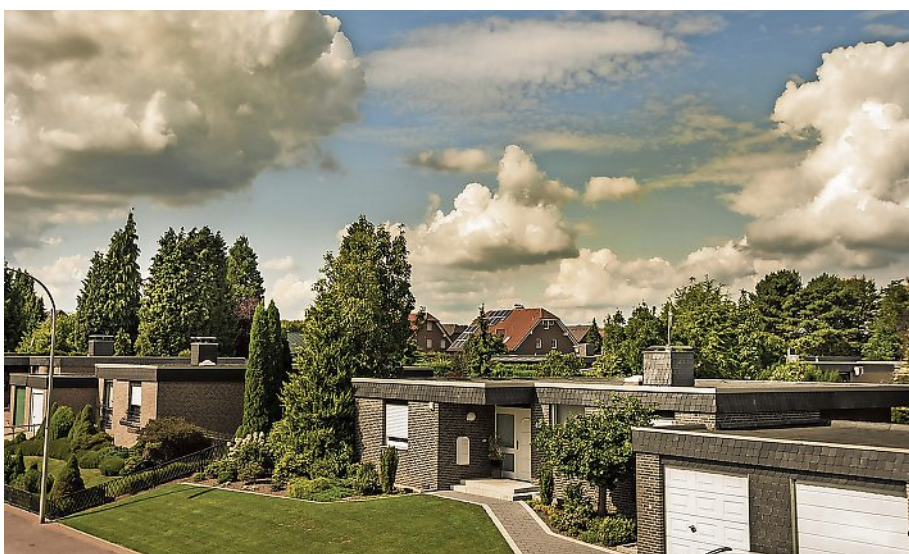
SOLCHE EINHEITLICHEN BUNGALOWSIEDLUNGEN IN KLINKEROPTIK WAREN AB DEN 1960ER-JAHREN IN DEN STÄDTEN WEIT VERBREITET.
