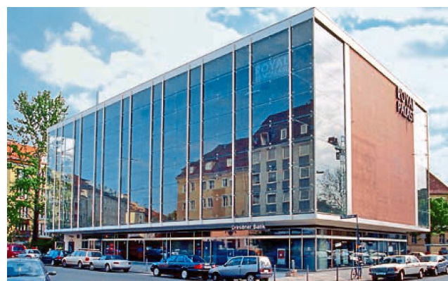
Ein schwebender Kubus, großflächig verglast. Der Royal-Filmpalast am Goetheplatz ist ein Sep-Ruf-Bau.
