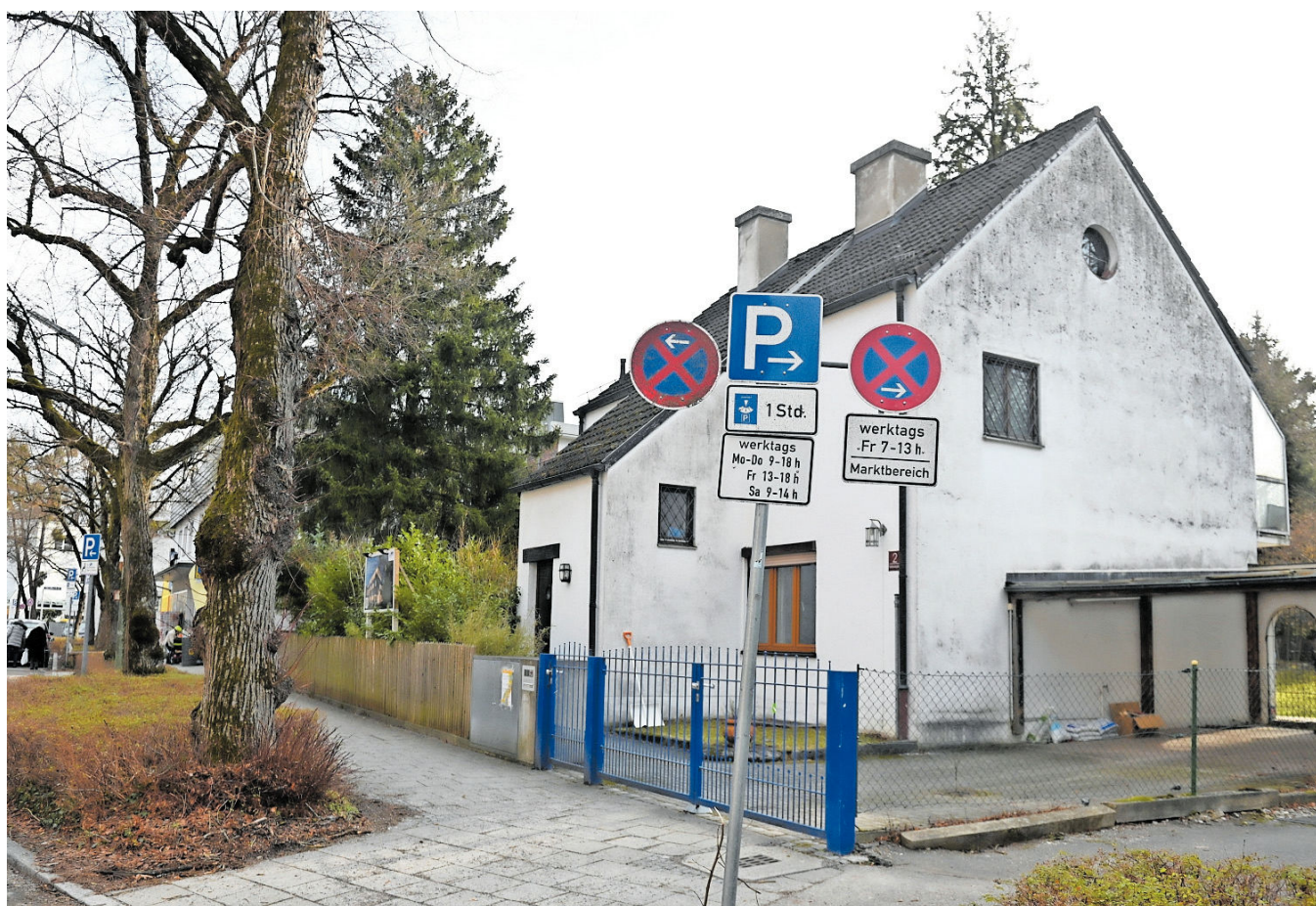
Das Haus hat einige typische Merkmale eines Sep-Ruf-Hauses: das Rundfenster im Giebel zum Beispiel. Das Landesamt für Denkmalpflege prüft die Denkmaleigenschaft des Hauses, das 1936 entworfen wurde. FOTOS: STEPHAN RUMPF
