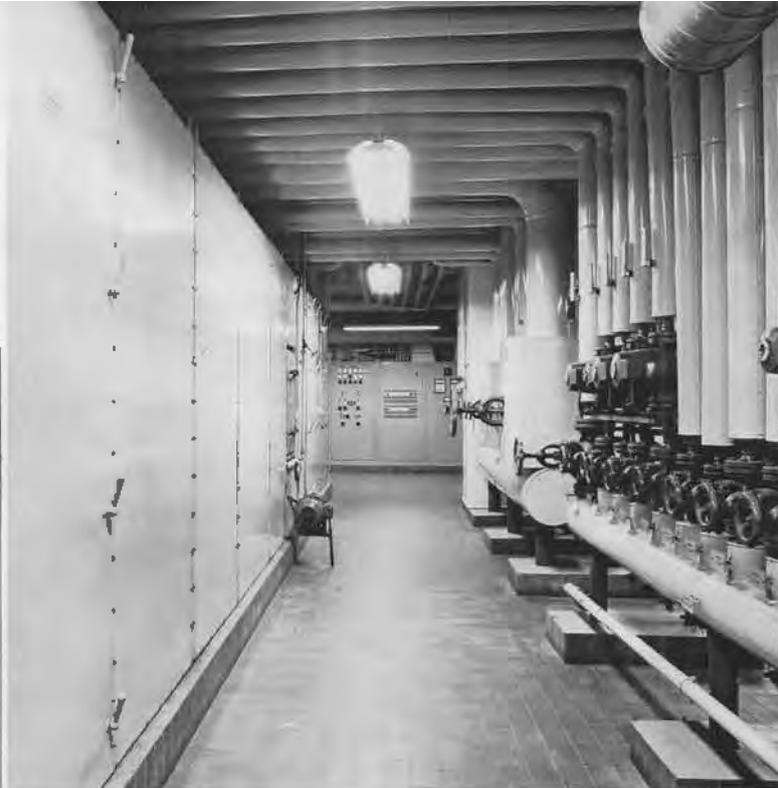
**Luftaufbereitungsgerät einer Zweikanalanlage für die Büroräume.**
