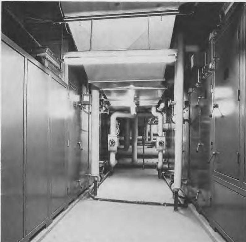
**Druckluftverteilerstation** für die pneumatischen Regelanlagen der Gewerke Wärme - Kälte - Dampf - Klima mit 19 Abgängen.
