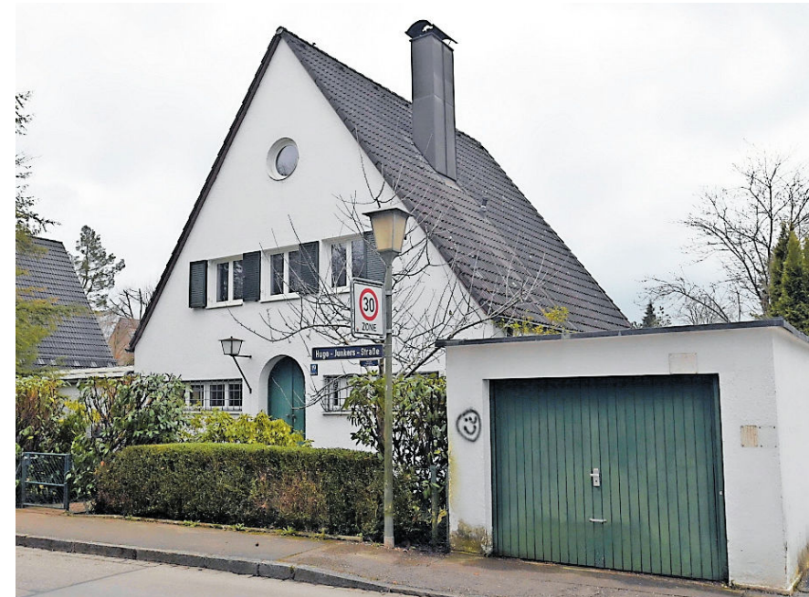
Für das Haus Hugo-Junkers-Straße 19 gibt es Umbaupläne. Diese können jedoch zumindest vorerst nicht umgesetzt werden.
