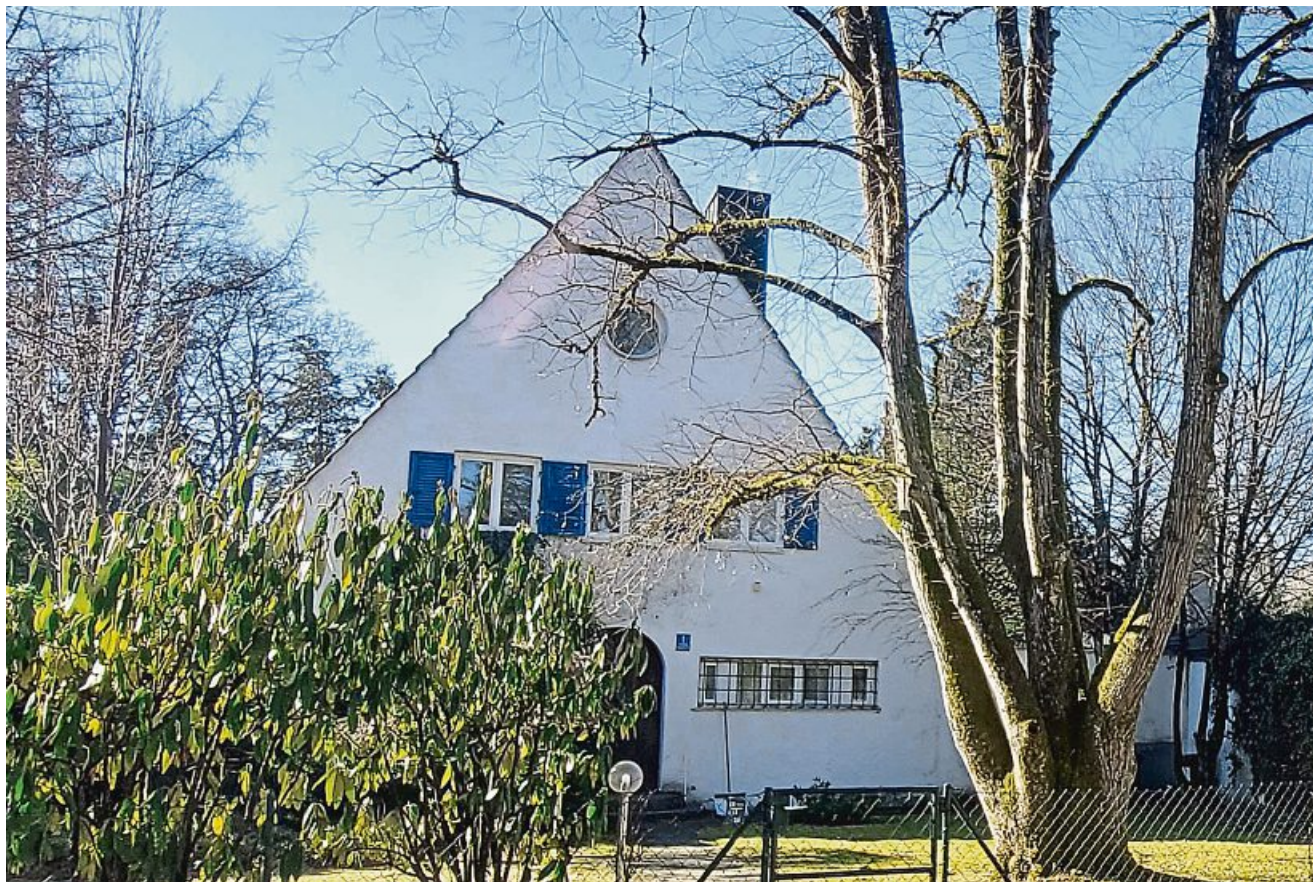
Der Abriss des Sep-Ruf-Hauses an der Hugo-Junkers-Straße ist zumindest vorerst abgewendet.
