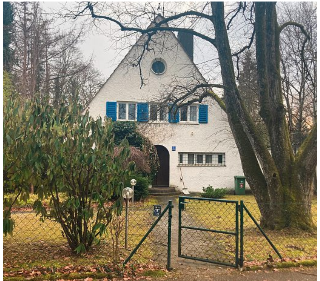
Dem von Sep Ruf geplanten Haus an der Hugo-Junkers-Straße 1 droht der Abbruch. Fs: dar, privat
