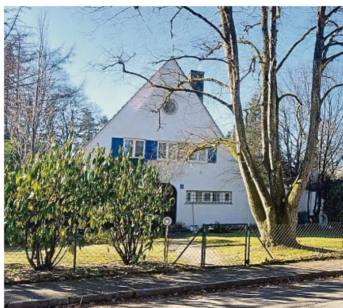
Eine Abrissuntersagung will die Gemeinde Grünwald für das Haus an der Hugo-Junkers-Straße 1 erwirken.
