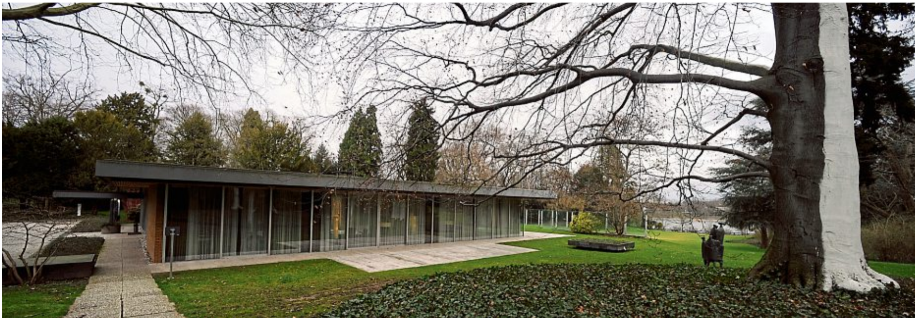
Der Kanzlerbungalow ist für elf Monate geschlossen, weil dort eine Brandmeldeanlage eingebaut werden muss.
