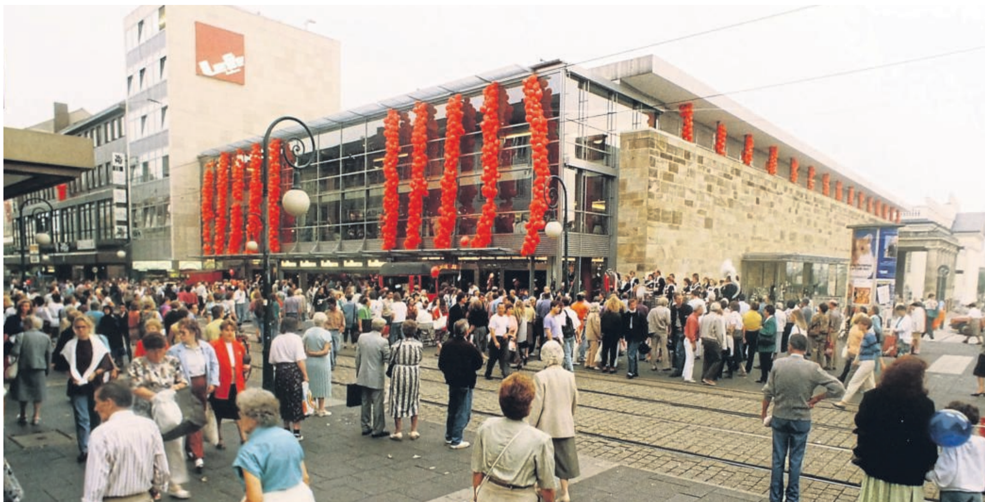
Großer Andrang im Sommer 1991: Damals feierte nach einem größeren Umbau das Modehaus Leffers die Eröffnung. Der Standort am Friedrichsplatz hat eine lange und wechselvolle Geschichte.
