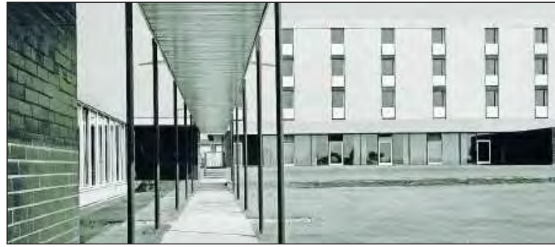
Überdacht: Weg im Außenbereich.
