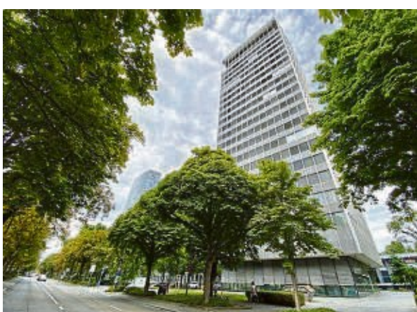
Das Westend-Duo steht auf dem Gelände des ehemaligen Hochtief-Hochhauses mit BHF-Bank im Vordergrund. FOTO: JAN HASENPLUG/STADT
