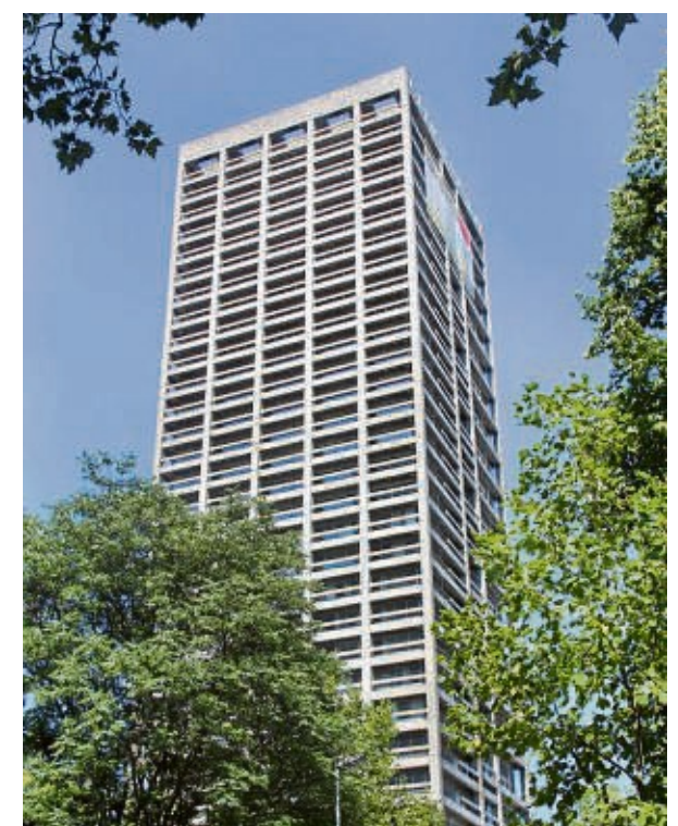
Im AFe-Turm wurden Generationen von Studenten unterrichtet, bis es 2014 gesprengt wurde. FOTO: STEFAN MAURER/STADT
