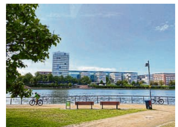
Das Bürozentrum der Allianz auf dem ehemaligen AEG-Gelände. FOTO: JAN HASENPLUG/STADT
