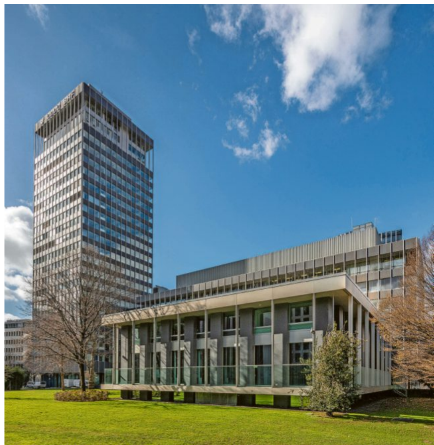
Elegantes Ensemble: Der 1965 errichtete Oddo-BHF-Turm steht unter Denkmalschutz. Von 2024 an soll er saniert werden.
