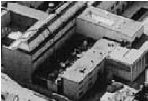
213 Germanisches Nationalmuseum, Werkstätten- und Wohngebäude am Nordende des Museums- geländes Nürnberg, Kornmarkt/Grasersgasse Ausführung: 1965–1968, Sep Ruf mit Harald Roth Eintrag in die Denkmalliste: 1997 Lit.: 280; 310; 346; 426, S. 41.
