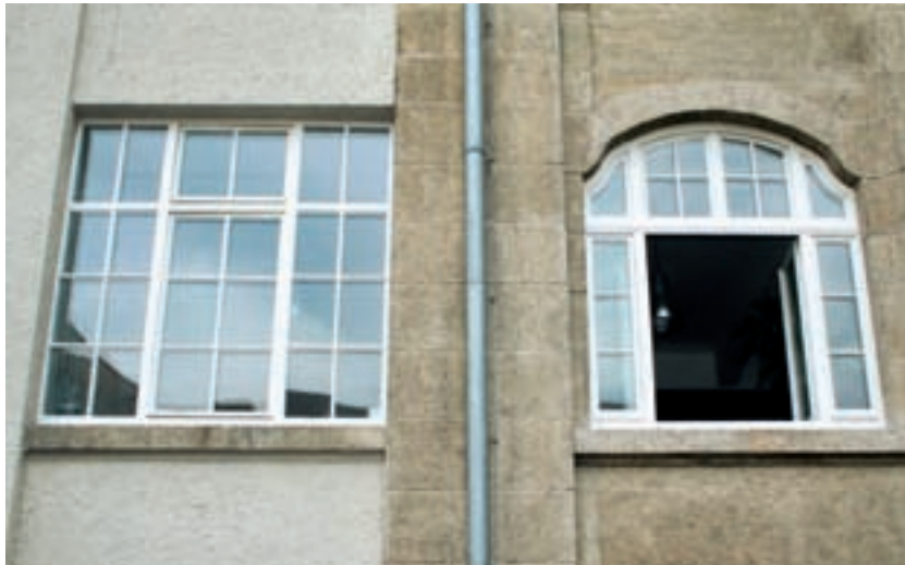
6 Ulm, Römerstraße 21; Bauaufnahme bauzeitliches Verbundfenster.
