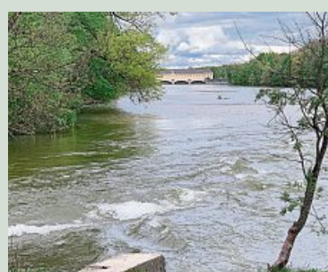
Hier mündet der Eisbach in die Isar. Hinten: das Stauwehr
