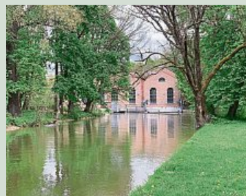
Das denkmalgeschützte Tivolikraftwerk
