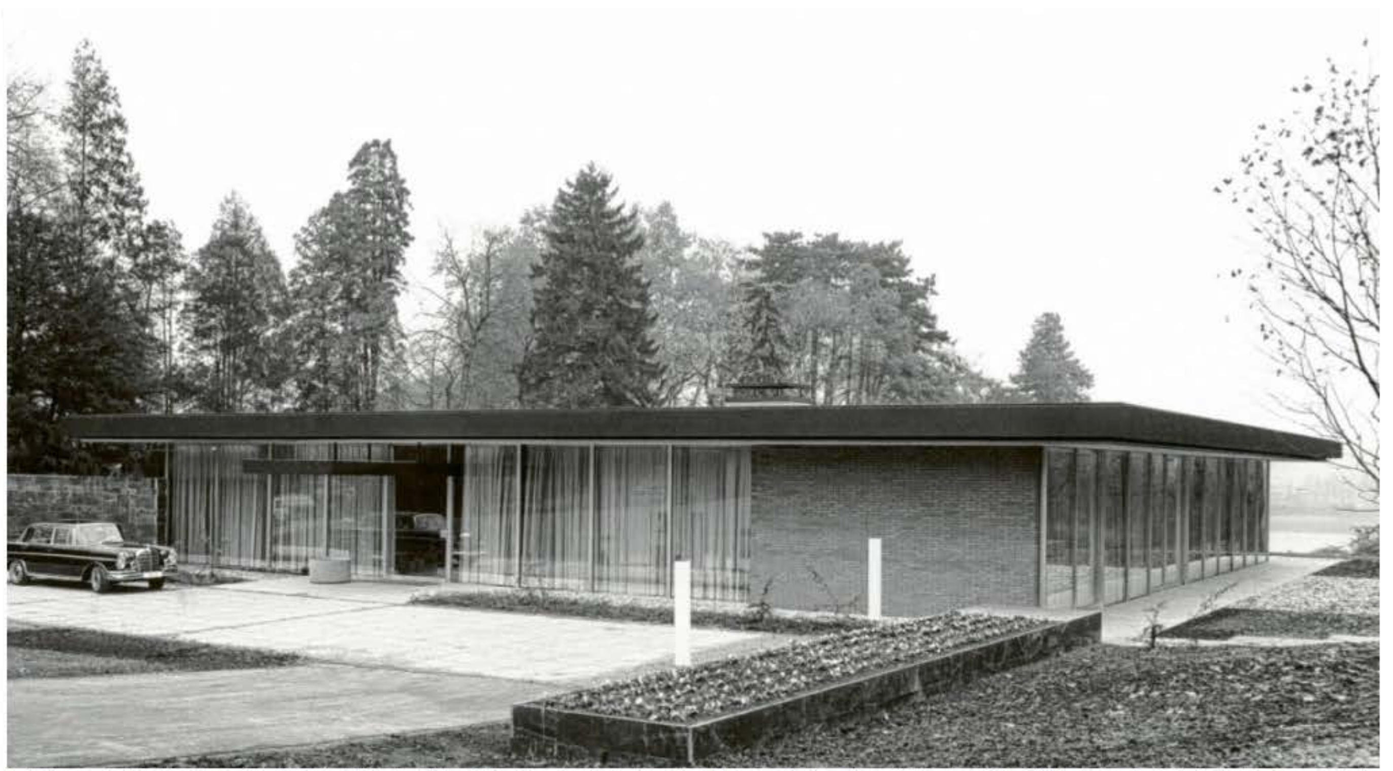
Im Auftrag von Ludwig Erhard entwarf Architekt Sep Ruf in den frühen 1960er Jahren den Kanzler-Bungalow in Bonn – mit seinen offenen Glasfronten ein Sinnbild für das demokratische Deutschland. Foto: dpa
