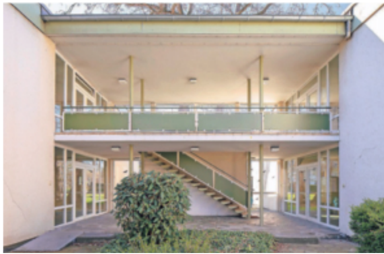
Luftig und filigran: Blick in ein „Schmetterlingshaus“ in der HICOG-Siedlung in Tannenbusch, ab 1951.
