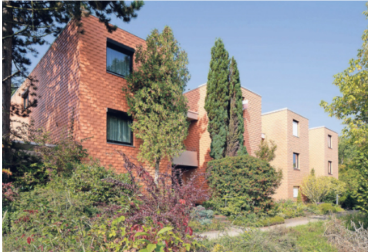
Wird als Denkmal diskutiert: Das Ensemble Oberer Lyngsberg (1971/72), als Teil des Demonstrativbauvorhabens des Bundes Heiderhof, bettet sich in die Landschaft ein.
