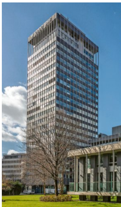
Baudenkmal: Der BHF-Turm wurde 1965 nach einem Entwurf von Sep Ruf errichtet.
