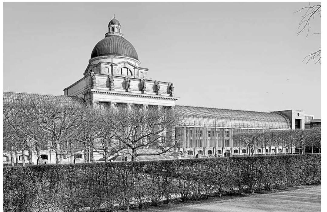
2020: Der restaurierte Kuppelbau mit den Anbauten der Staatskanzlei, die 1989 fertig geworden ist.
