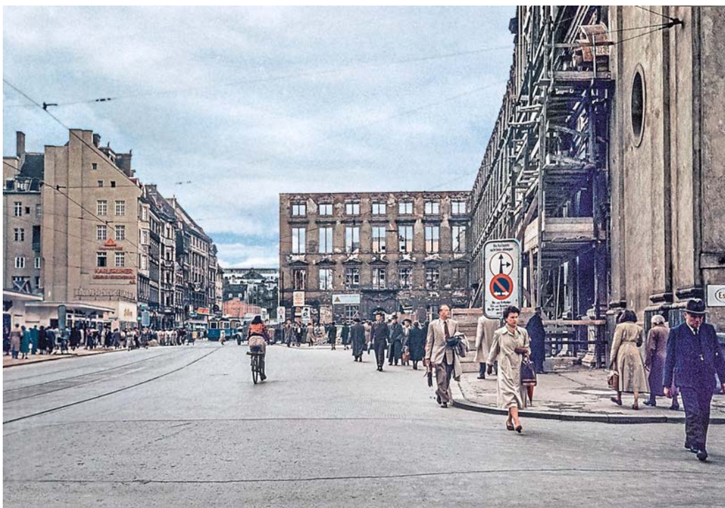
1953: St. Michael und die erhaltenen Fassaden der Alten Akademie, links gähnt eine riesige Baulücke.
