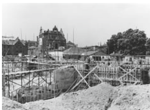
Baustelle, im Hintergrund das Künstlerhaus am Lenbachplatz
