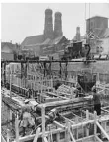
Erdarbeiten, im Hintergrund die Frauenkirche
