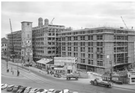
Maxburg-Baustelle zur Zeit des Richtfestes, November 1954
