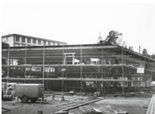
BMW-Pavillon im Bau
