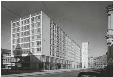
Pacelliblock, Einbindung des Turms der Alten Herzog-Max-Burg in das neue Ensemble
