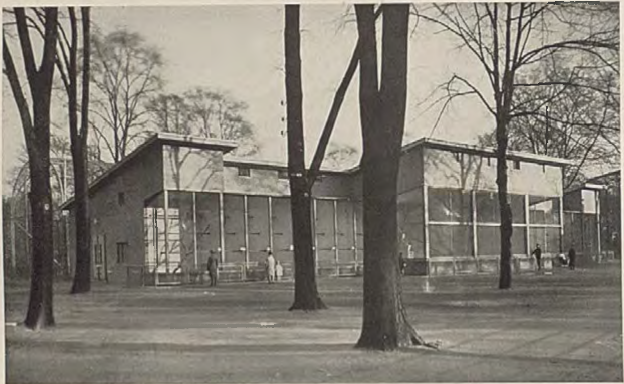
Das neue Affenhaus, Gesamtansicht von Süden. Entwurf Reissinger-Düsseldorf
