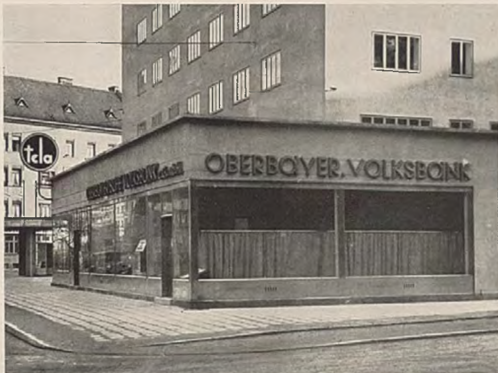
Oben niedriger Anbau mit Konditorei und Bankfiliale. Wie beim Hauptbau sind auch hier die Fensterflächen mit der Außenwandfläche nahezu bündig. (Blick aus der Deisenhofener Straße.) (Konstruktive Einzelheiten auf Tafel 30)
