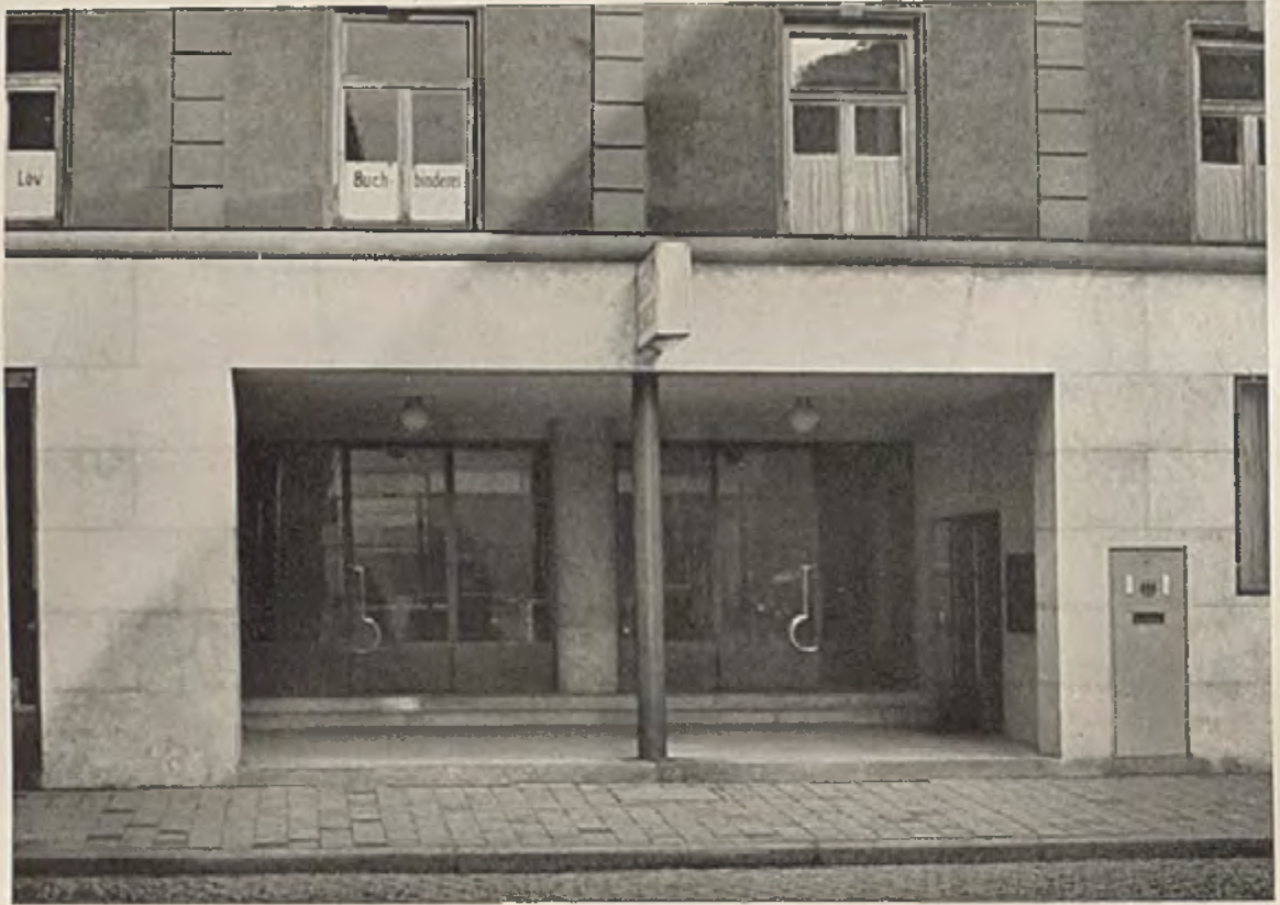
Postamt an der Theresienstraße, Einbau
