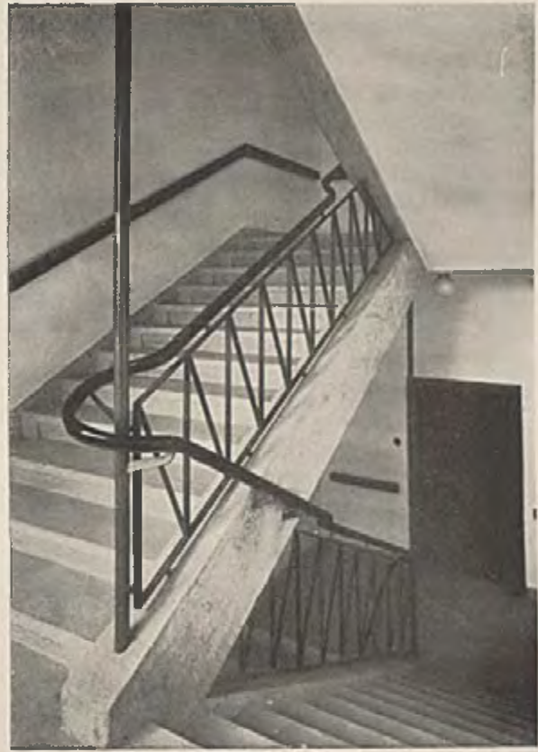
Postamt an der Tegernseer Landstraße Links Pendeltüre zur Schalterhalle; rechts Treppe mit Kunststeinstufen auf Eisenbetonplatte
