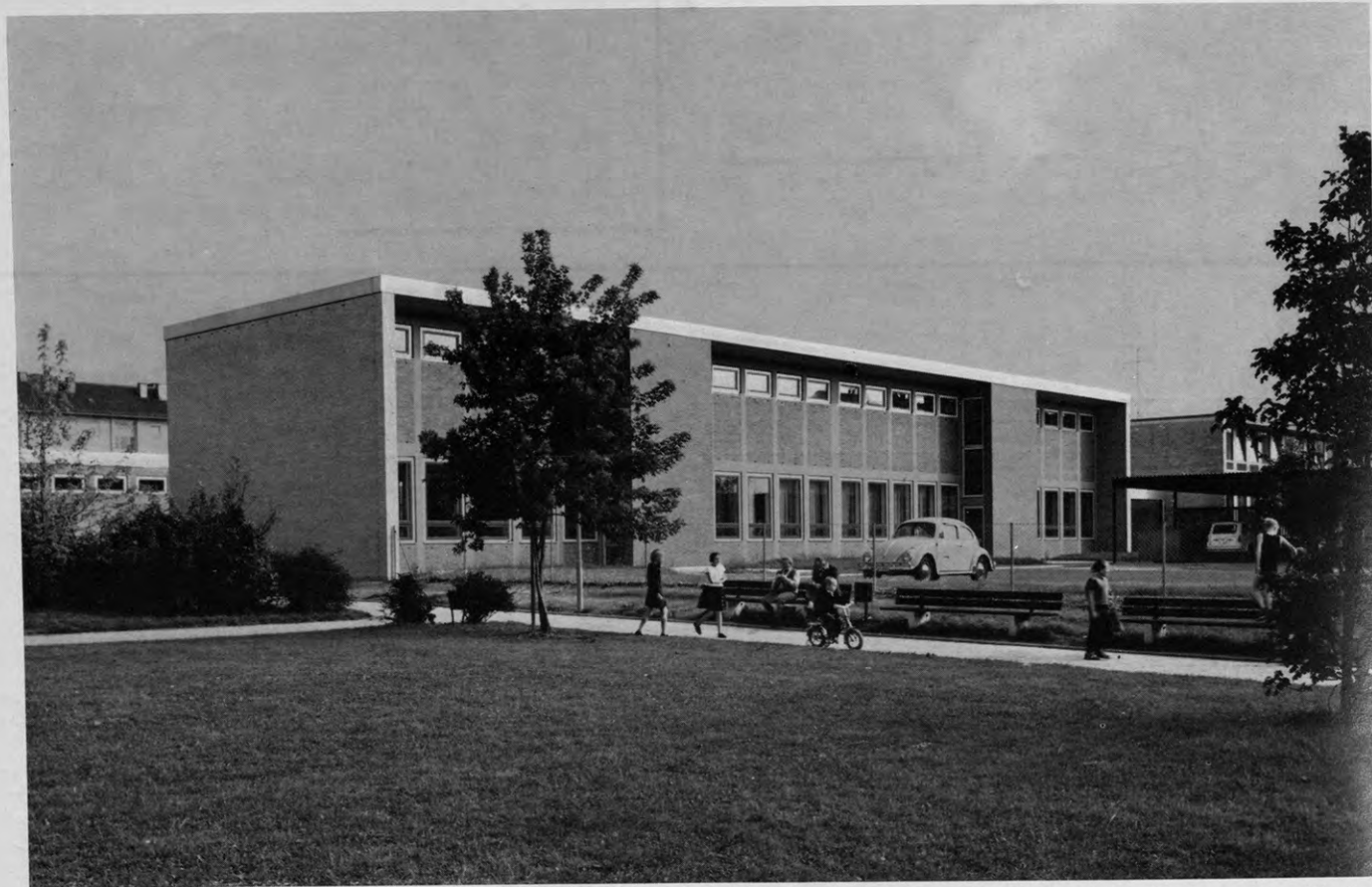
Lehrsaaltrakt des II. Bauabschnittes von Nord-Westen
