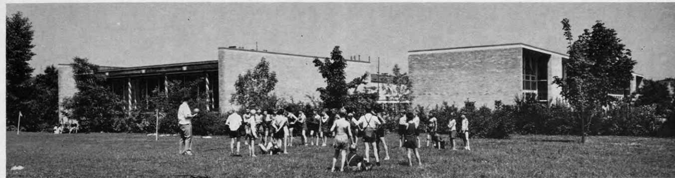
I. Bauabschnitt Turnhalle und Lehrsaalbau von der Spielwiese aus.
