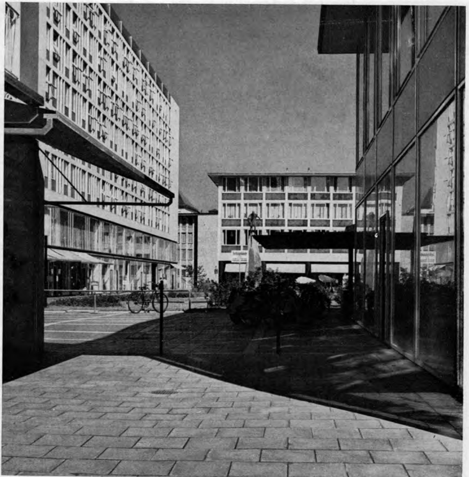
Durchgang zum Innenhof vom Lenbachplatz. Links die Front des Pacelli-Blockes mit Läden zum Innenhof. Im Vordergrund Fahrrad-Abstellanlagen
