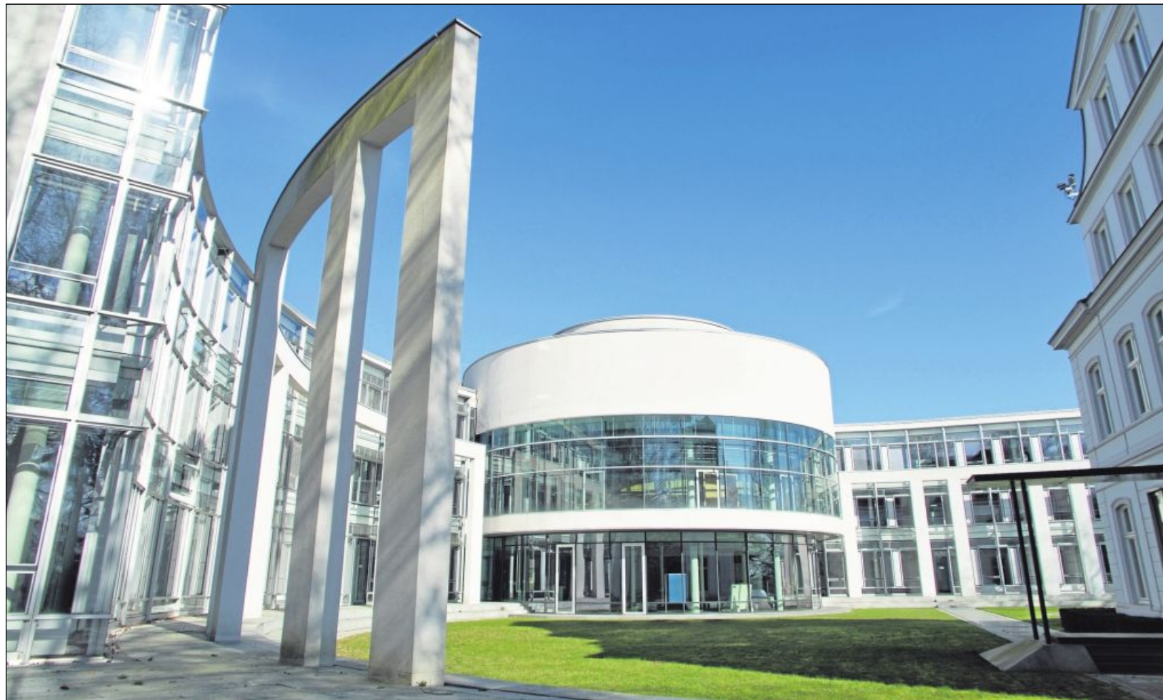
Großes Architekturtheater: Internationaler Seegerichtshof Hamburg (Wettbewerb 1989, gebaut 1990–2000), Alexander Freiherr von Branca mit Emanuela Frein von Branca.
