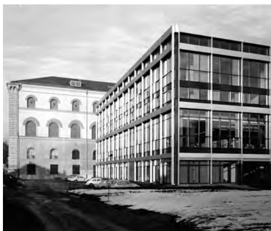
Erweiterungsbau von Südosten, ca. 1968
