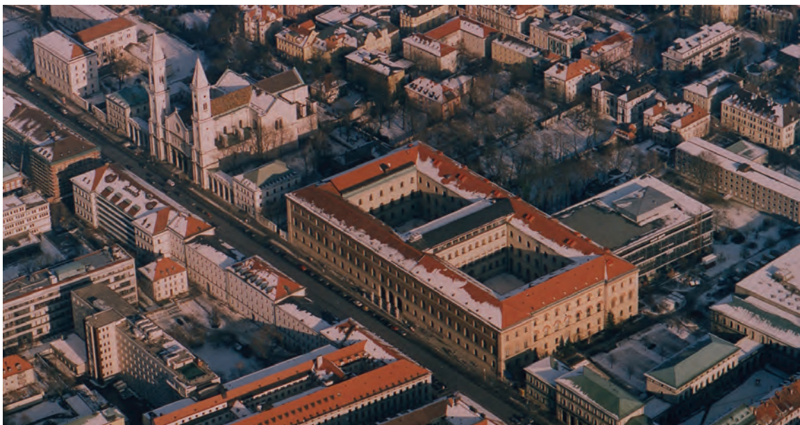
Luftbild der Bayerischen Staatsbibliothek (Ausschnitt): Der Ostflügel erstreckt sich längs (in der Bildmitte) parallel zum Straßentrakt. Am rechten oberen Bildrand, angeschlossen an den südlichen Arm des Ostflügels, ist der Erweiterungsbau zu sehen.
