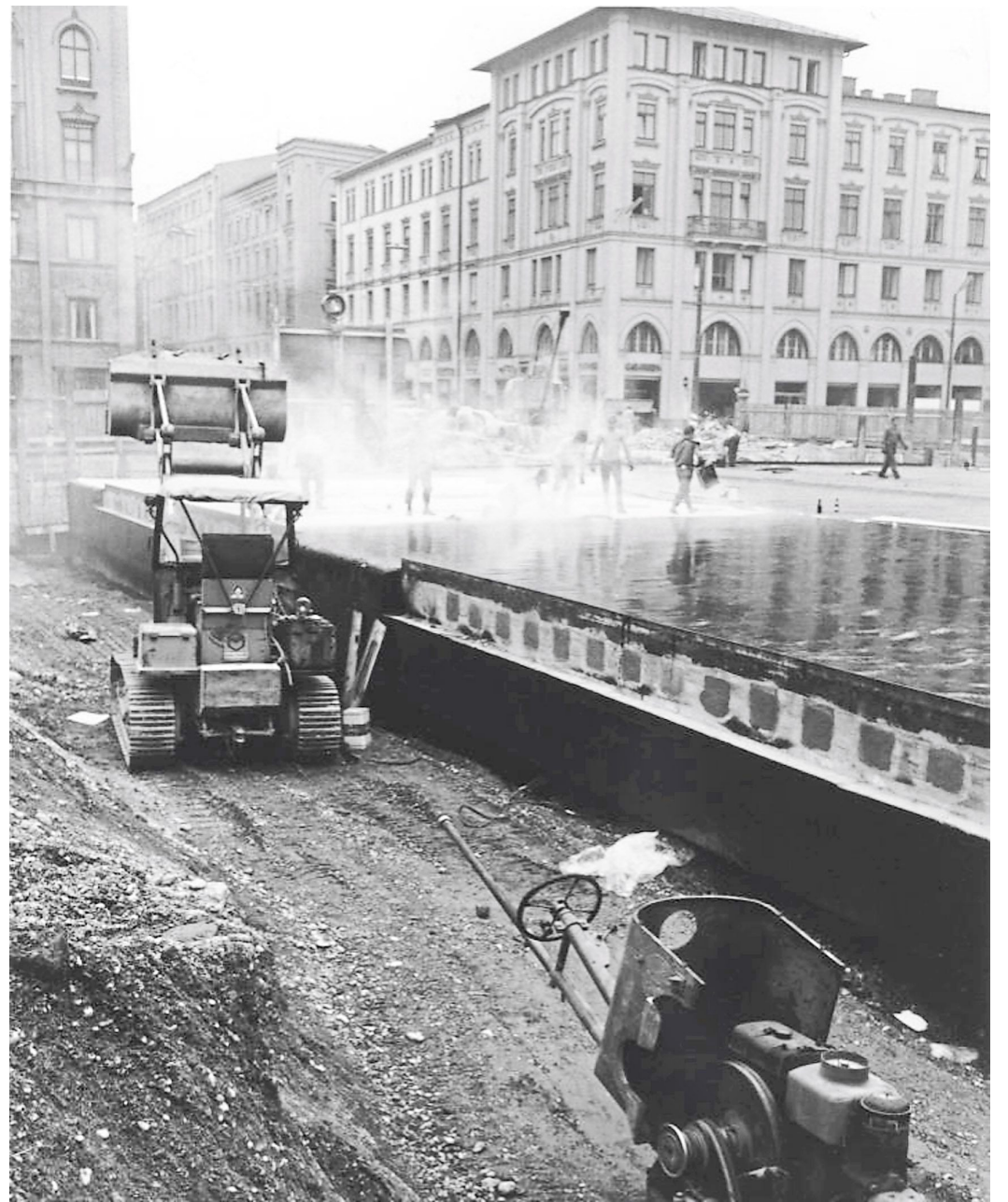
Offene Wunde: Arbeiten am Altstadtring an der Kreuzung zur Maximilianstraße 1968 – hier wird er sogar noch einmal vorbereitet.
